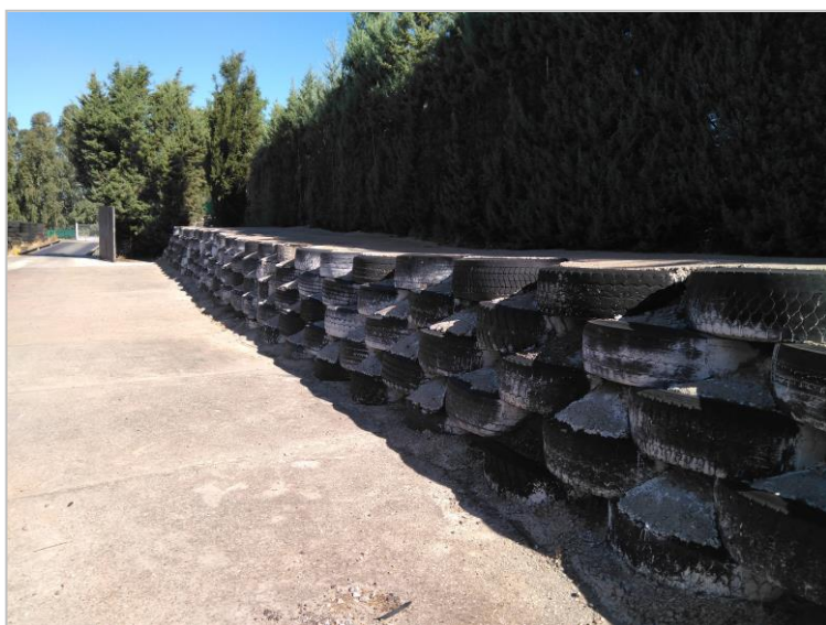
En la valorización material se utilizan tanto neumáticos enteros, por ejemplo, en la construcción de taludes, como triturados, siendo ésta última la forma más habitual de utilización.
